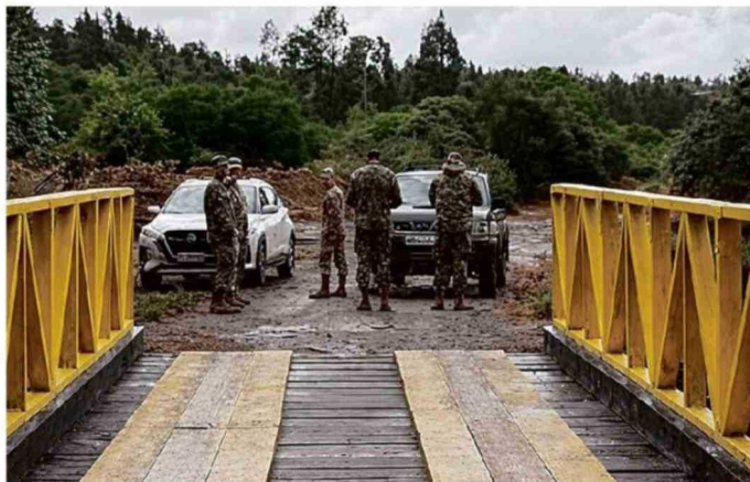
LA OBRA PERMITIRÁ MEJORAR LA CONECTIVIDAD PARA LAS FAMILIAS DEL SECTOR.
