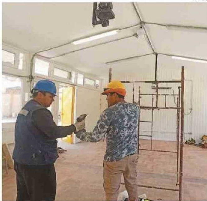
SE TRABAJA EN LA CLIMATIZACIÓN DE LA ESCUELA ABEL GUERRERO.
