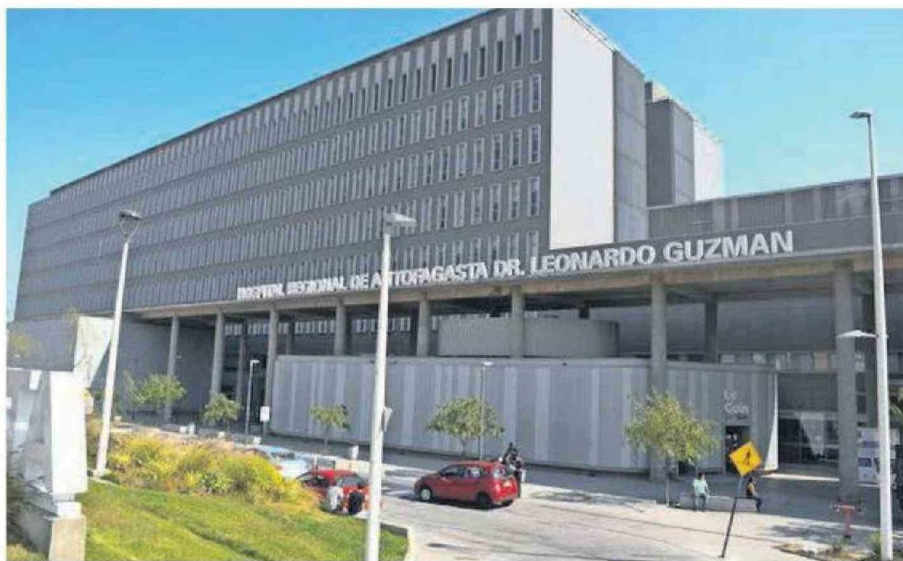
NUEVAMENTE EL HOSPITAL SE VIO AFECTADO POR UNA FILTRACIÓN DE AGUAS.
