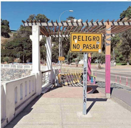
LOS TRABAJOS DEBIERAN CONTINUAR POR AV. ALTAMIRANO.
