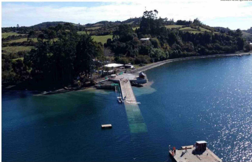
EN LA FASE DE TERMINACIONES SE ENCUENTRAN LOS TRABAJOS EN LA ISLA QUINCHAÍNA.
