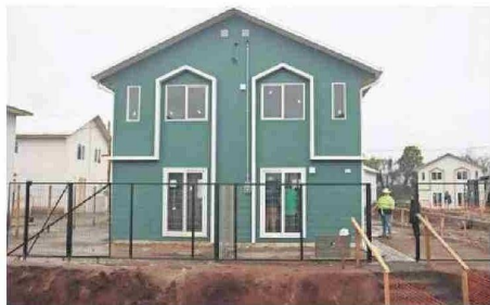
Proyecto contempla acceso controlado y áreas comunes.
