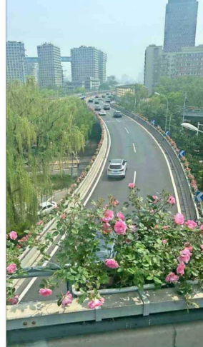
Este cruce de autopistas en Beijing muestra algunos elementos paisajísticos que integran la infraestructura vial al entorno.
