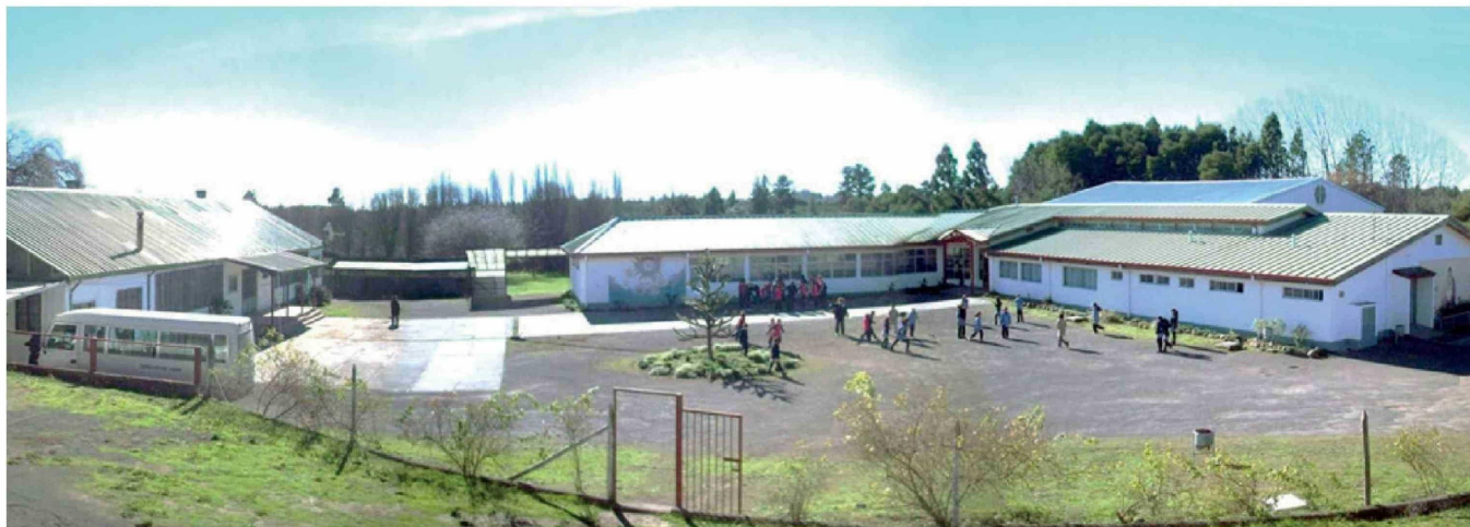
APODERADOS RETIRARON A SUS HIJOS durante el primer día de clases tras detectar fecas de roedor en el comedor y la cocina del establecimiento, ubicado en la Ruta Cinco, al norte de Los Ángeles.
