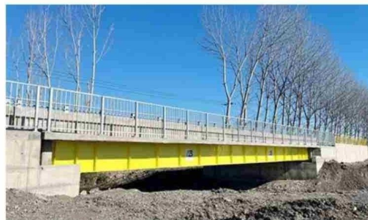
PUENTE LAS ARAÑAS DE PALMILLA.
