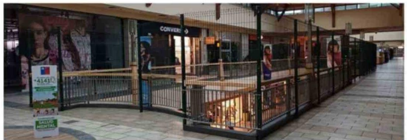
EN UNA SEGUNDA ETAPA SE CAMBIARÁN ESTAS BARRERAS METÁLICAS POR CRISTAL TEMPLADO.
