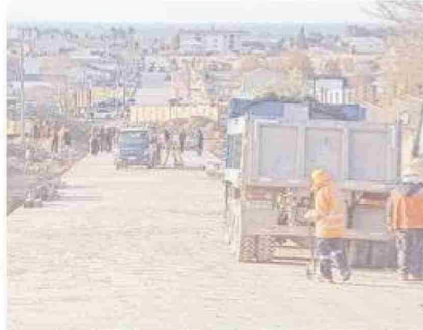
Una vista de cómo está quedando la pavimentación de calle Ovejero, de cerro a playa.
