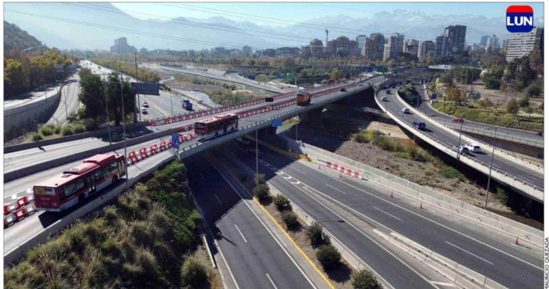
El puente opera con dos de tres pistas por lado. Luego bajará a una por lado.
