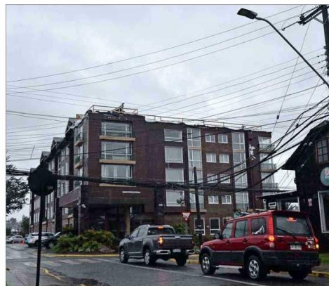
ABIERTO. — En infraestructura turística, el mayor daño lo recibió el techo del Hotel Solace (en la foto), que aún está con trabajos pero funcionando.
