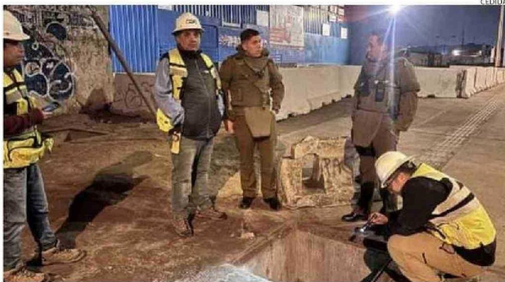
La empresa CGE repuso el servicio tras realizar trabajos en el sector de Trocadero.
