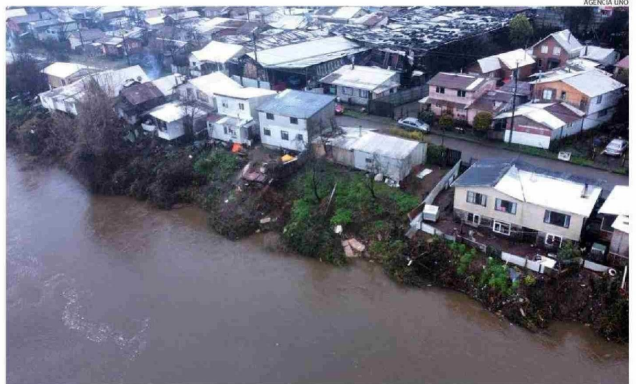
EN LA POBLACIÓN ALDAY, LAS VIVIENDAS UBICADAS ENTRE CALLE CAUPLICÁN Y EL RÍO RAHUE ESTÁN CON EL AGUA EN SUS PATIOS.
