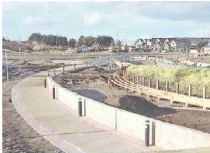
Aspectos del avance de las obras en el sector de Hornillas-Manantiales.
