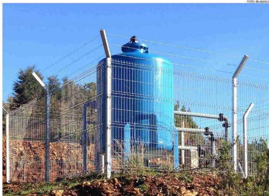
LA CONSTRUCCIÓN DE UN SERVICIO SANITARIO RURAL (EX APR) PUEDE TOMAR MÁS DE 10 AÑOS SÓLO POR LA TRAMITACIÓN DE AUTORIZACIONES.
