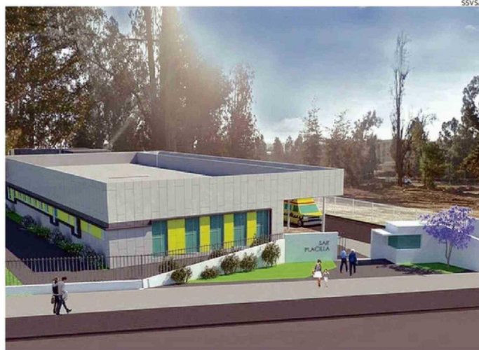
PROYECTO BUSCA MEJORAR LAS CONDICIONES EN SALUD DE LOS VECINOS DE PLACILLA DE PEÑUELAS.
