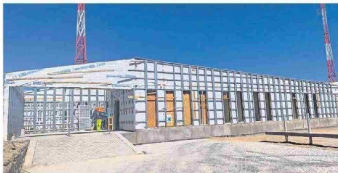
TRABAJOS ESTÁN FINANCIADOS CON FONDOS DEL FNDR Y CARABINEROS DE CHILE.
