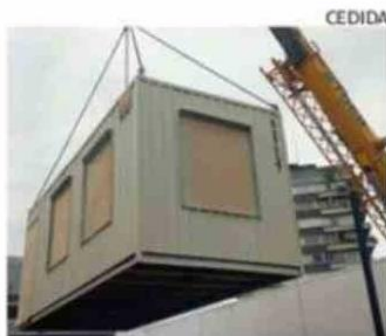
CEDIDA LAS NUEVAS AULAS MODULARES.
