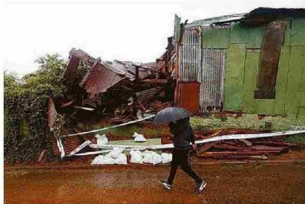
EN EL CERRO FLORIDA, UNA VIVIENDA RESULTÓ CON DAÑOS SEVEROS.
