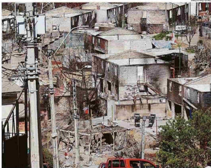
EN LAS ZONAS AFECTADAS LA MAYORÍA SIGUE ESPERANDO POR SUS CASAS.
