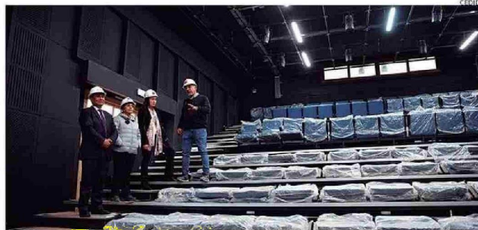
LA MINISTRA DE OBRAS PÚBLICAS JÉSSICA LÓPEZ REALIZÓ UNA VISITA A LAS OBRAS.
