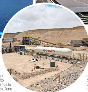
Planta GASCO de calentamiento de pilas de lixiviación.
