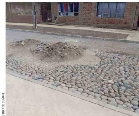
En Avenida Colón avanza la obra bajo la técnica
