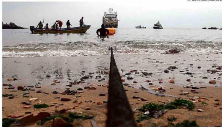
ANCLAJE TERRESTRE EN PLAYA ANCHA DE LA FIBRA ÓPTICA SUBMARINA "CURIE", DE GOOGLE, REALIZADO EN 2019.
