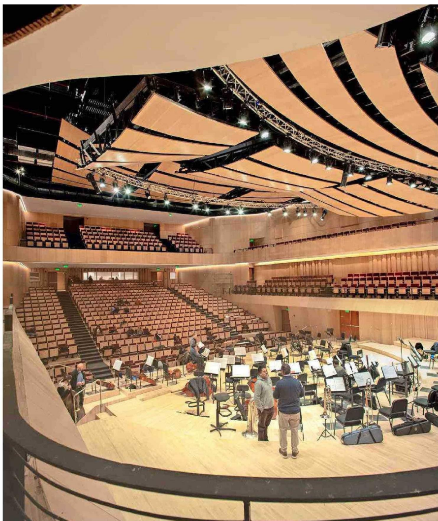
La gran sala sinfónica cuenta con un plafón acústico suspendido sobre el escenario.
