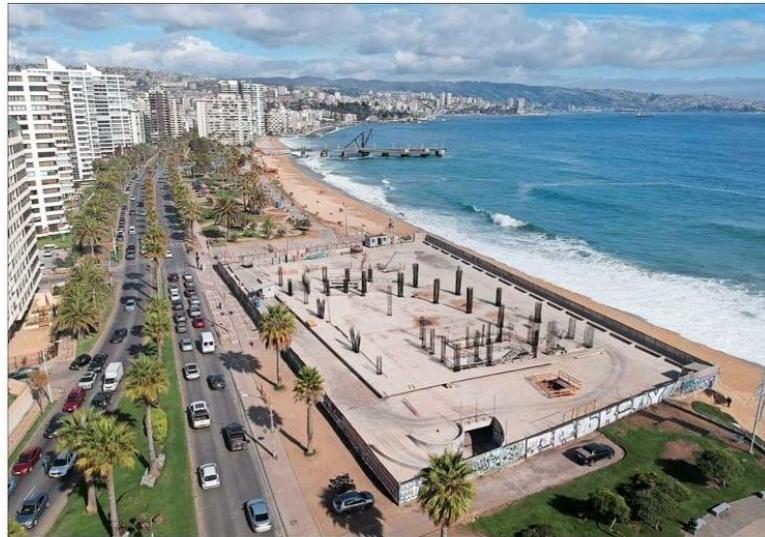
Así va la construcción del hotel.
