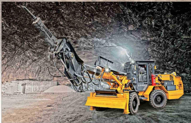
La acuañadora de Soilfe sirve para remover material que pueda desprenderse dentro de los túneles mineros.
