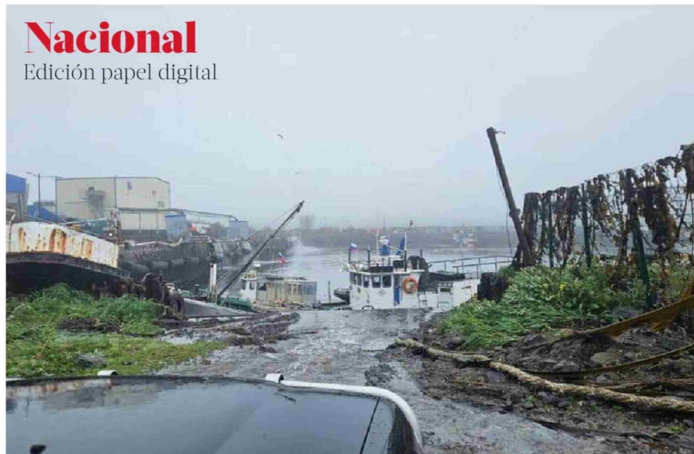
► Las olas provocaron graves daños en la zona portuaria de Severo-Kurilsk, en las Islas Kuriles de Rusia, tras el impacto del tsunami.
