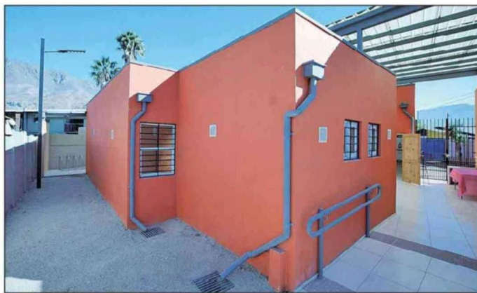
Sede cuenta con accesibilidad universal, cocina, baños, sala de reuniones, salón principal, mudador, cierre perimetral, zona de reciclaje y biciclettero.
