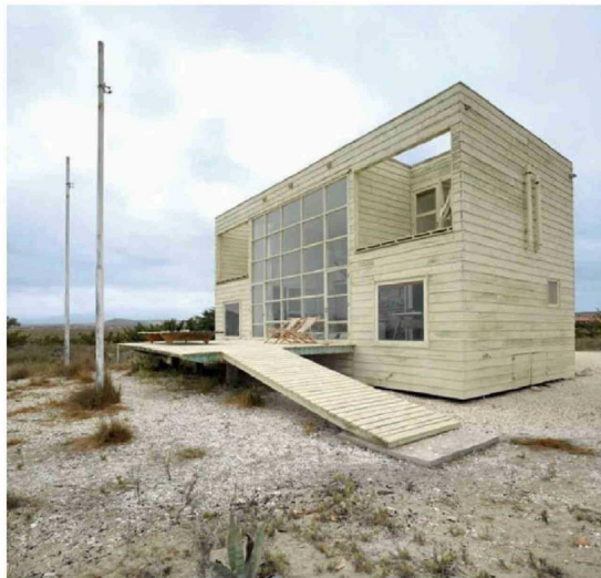
► Casa Klotz en Tongoy, diseñada por Mathias Klotz en 1991.
