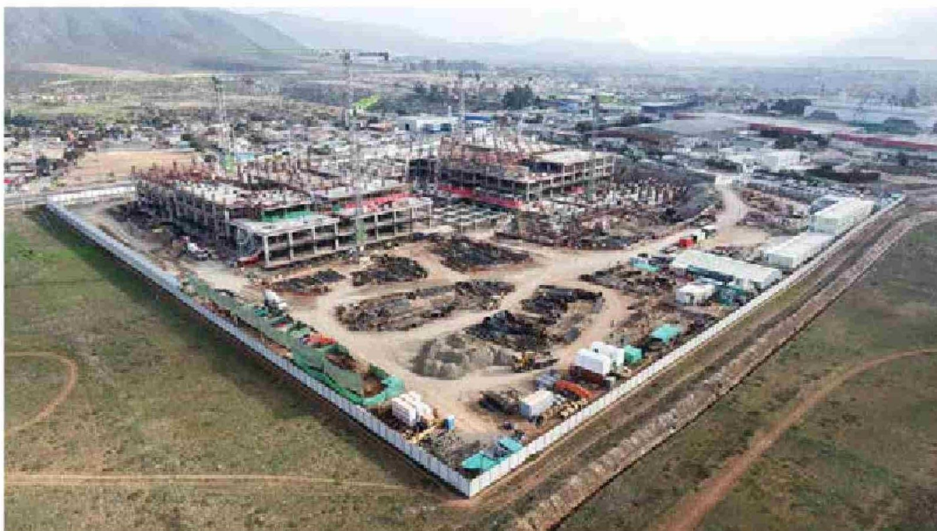
MINISTRA DE SALUD, XIMENA AGUILERA, CONSTATÓ LA EJECUCIÓN DEL MEGAPROYECTO:
