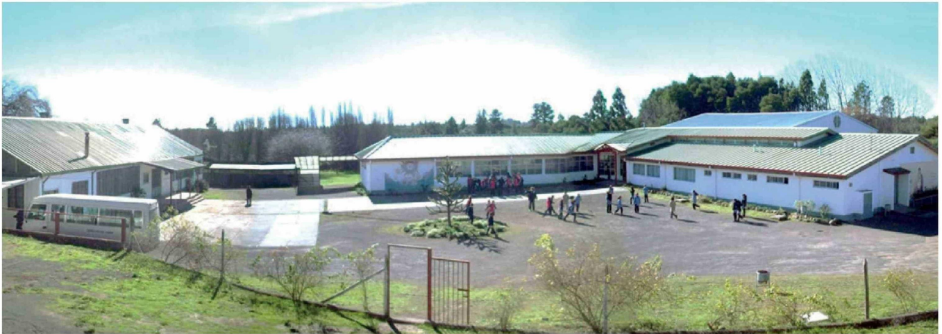
APODERADOS RETIRARON A SUS HIJOS durante el primer día de clases tras detectar fecas de roedor en el comedor y la cocina del establecimiento, ubicado en la Ruta Cinco, al norte de Los Ángeles.
