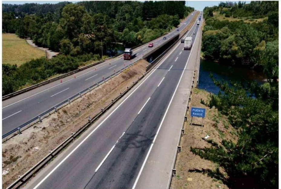
LAS RESTRICCIONES DEL PUENTE RAHUE ORIENTE, UBICADO EN LA RUTA 5, COMENZARON HACE VARIAS SEMANAS Y ESTÁN SEÑALIZADAS.
