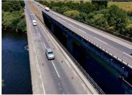
LA CIRCULACIÓN POR EL PUENTE RAHUE ORIENTE ES POR UNA PISTA.
