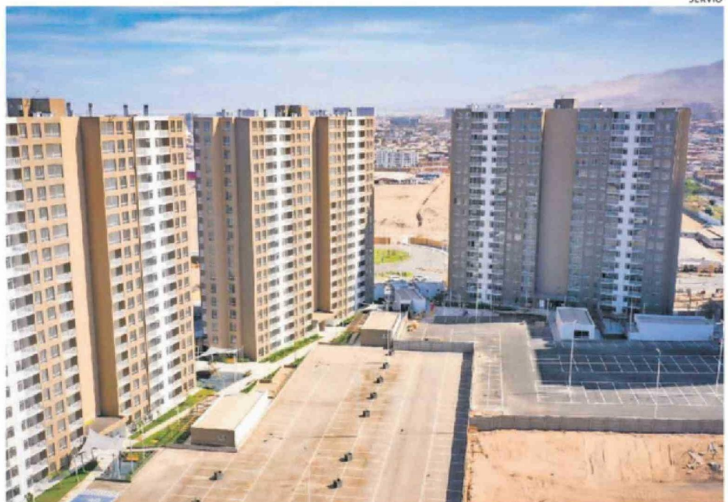
EL PROYECTO LAS VICUÑAS 1 ESTÁ TERMINADO.
