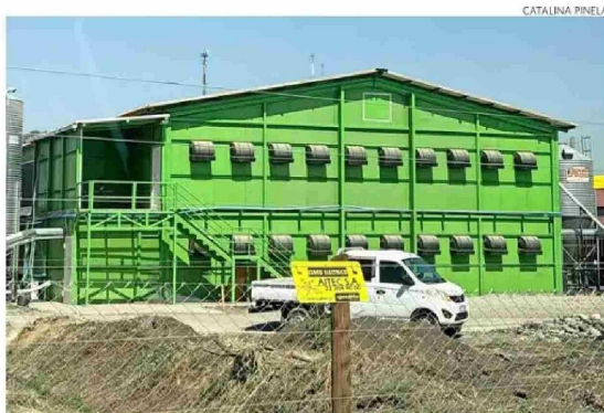
Los galpones tienen extractores para sacar el calor que producen las mismas gallinas.
