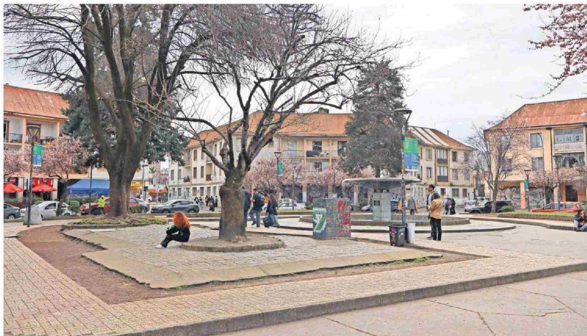
Para un menor impacto en el tránsito diario, las obras serán por etapas y la primera de ellas -ya iniciada- es en el sector de la pileta.
