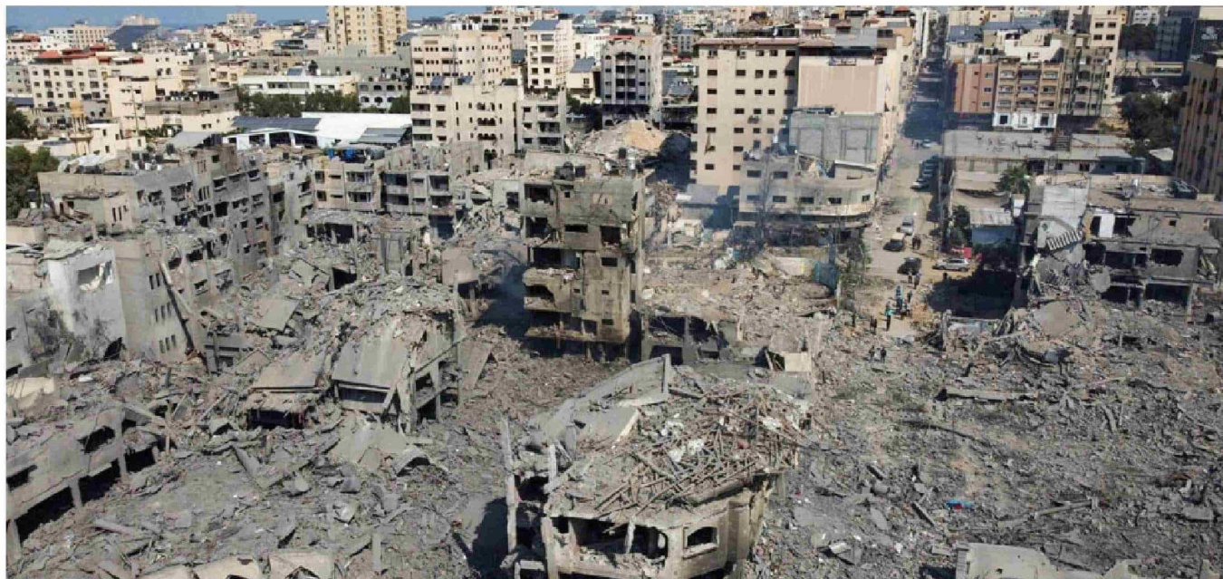
► Vista panorámica de casas y edificios destruidos por ataques en la ciudad de Gaza.
