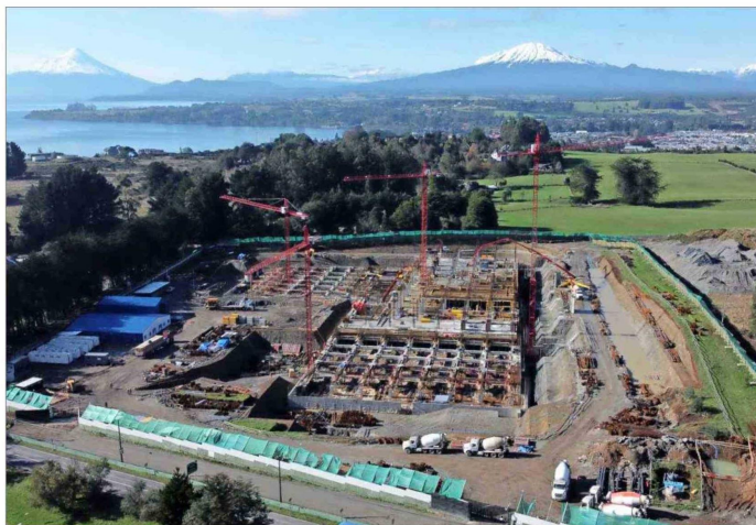
ATRASADO.— El Hospital de Puerto Varas es uno de los recintos que se encuentran en construcción.
