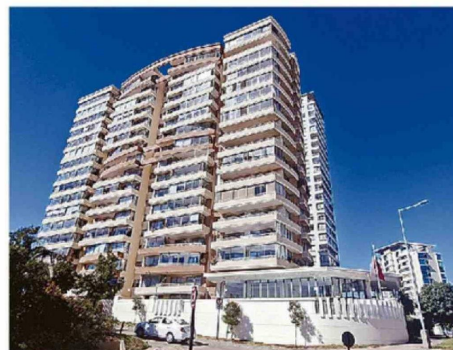
EL “MIRADOR CORACEROS” ES EL EDIFICIO MÁS AFECTADO.
