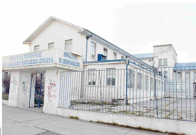
El ex Hospital Regional se encuentra a un paso de poder ser demolido tras años de abandono.
