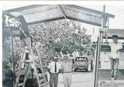
En la escuela de San Miguel de Azapa se contruyeron sombreaderos, hubo arreglos de duchas y cambio de radier. (02/01/1992).
