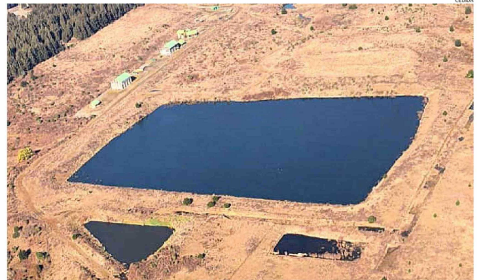
EN LA PISCINA GRANDE SE ACUMULARON 200 MIL METROS CÚBICOS DE AGUA, LOS QUE ESTÁN SIENDO EXTRAÍDOS DESDE HACE UN MES.
