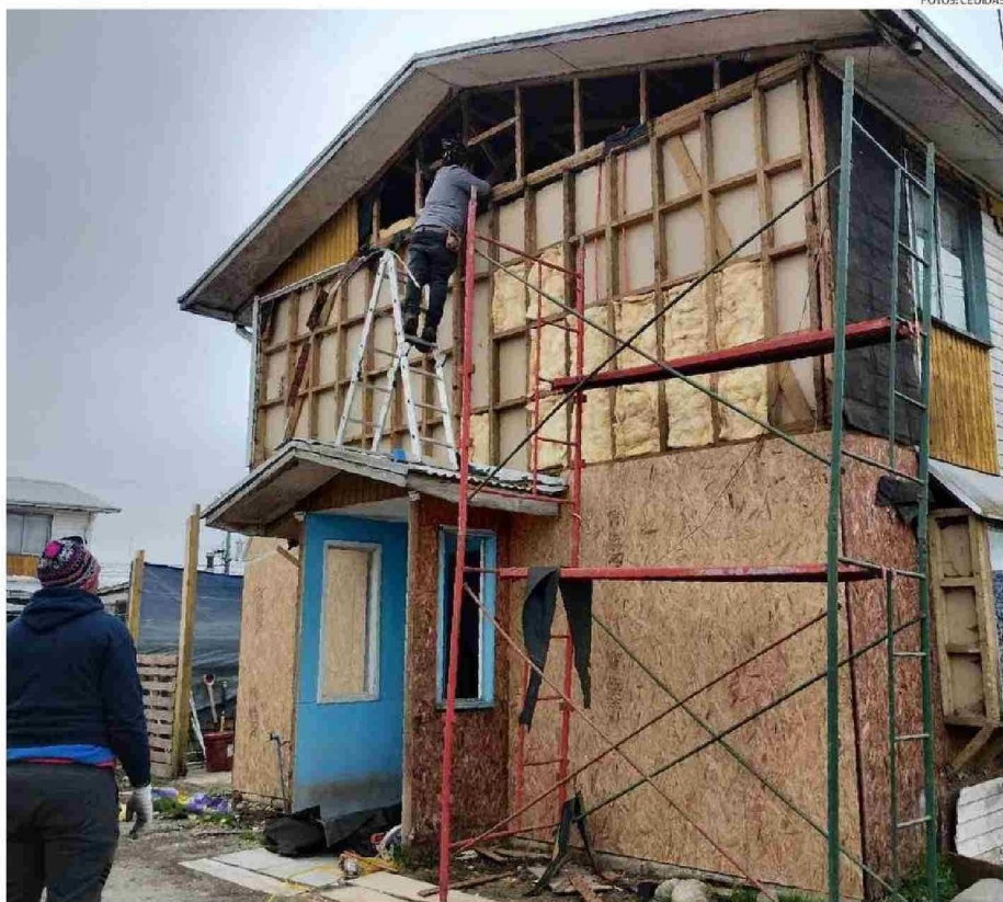
LAS REPARACIONES SUBSIDIADAS POR EL MINISTERIO DE VIVIENDA HAN SIGNIFICADO UN BENEFICIO PARA MILES DE FAMILIAS.
