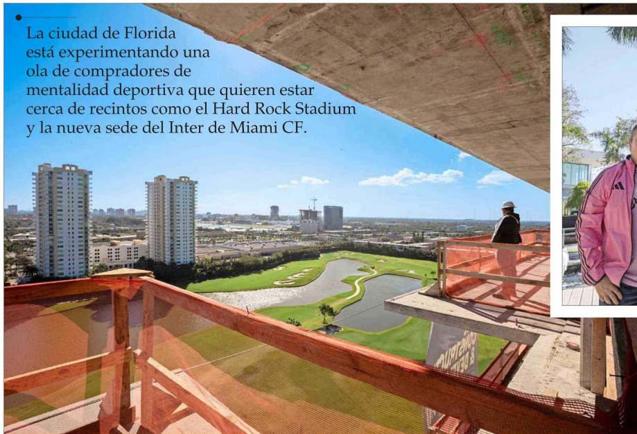
Residences at Shell Bay es un condominio de lujo en construcción ubicado en Hallandale Beach.
