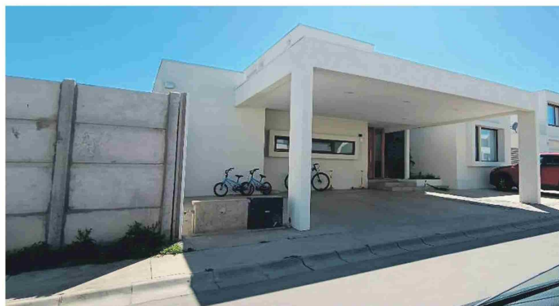
El propietario modificó el frontis de su casa con este techo y los pilares que lo soportan.
