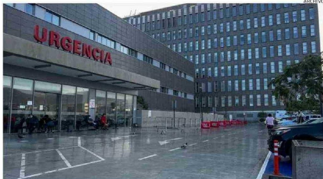
La dirección del hospital informó que falló una válvula liberadora de presión de una caldera.
