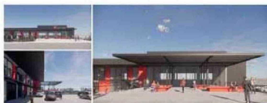
Foto referencial nuevo edificio INACAP sede Calama.
