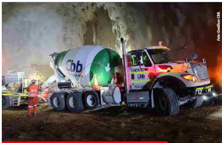
CBB en el proyecto Mina Chuquicamata Subterránea.
